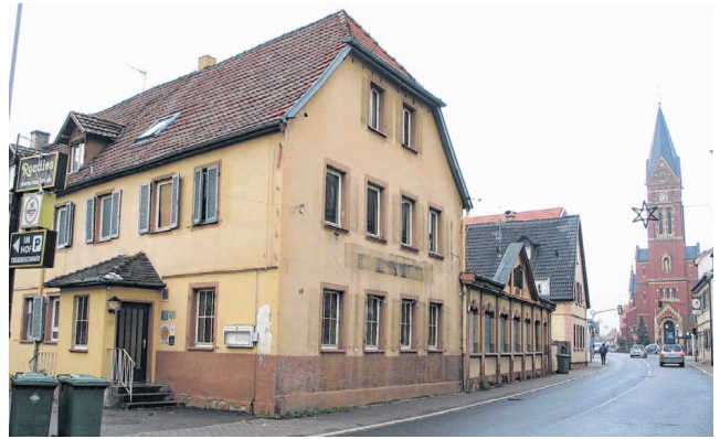
Der „Adler“ samt Anbau soll einem Supermarkt weichen, auch der Mack'schen Schmied im Hintergrund droht der Abriss. Wo heute die drei Gebäude stehen, soll sich später einmal ein Parkstreifen vor einem Einkaufsmarkt erstrecken.
